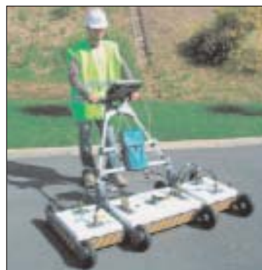
Fig. 5: Apparecchiatura Georadar per la mappatura dei sottoservizi
