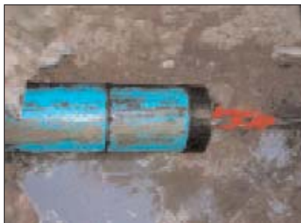
Fig. 26: Dettaglio dell'intervento di slip-lining
