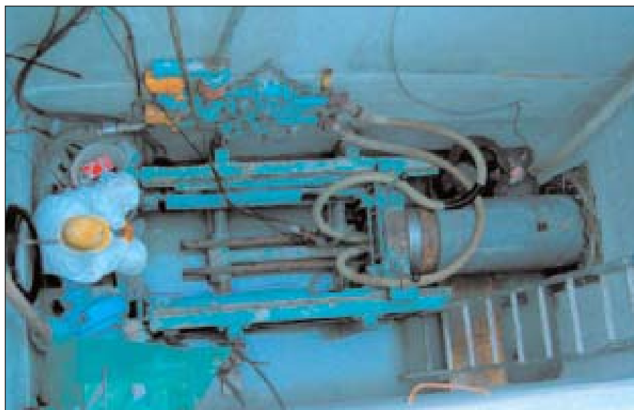
Fig. 21: Pozzo di spinta dell'intervento di microtunneling presso il Comune di Castelnuovo del Garda
