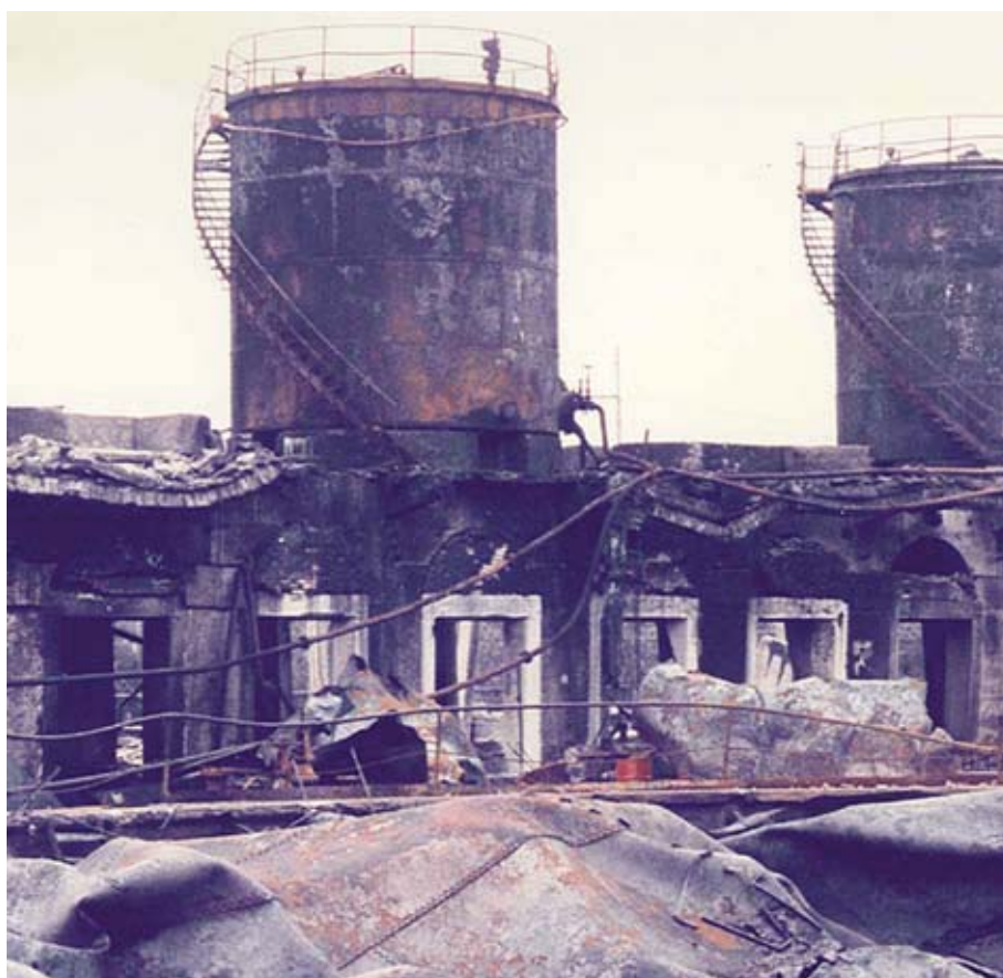
Figura 4.1.1 - Parte del deposito costiero Agip di Napoli dopo l'incidente del 1985
