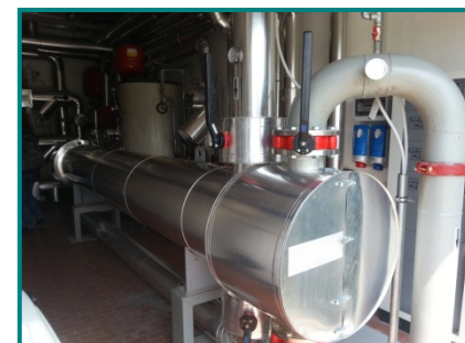
Scambiatore di calore in uso a valle del Depuratore di Milano Nosedo
