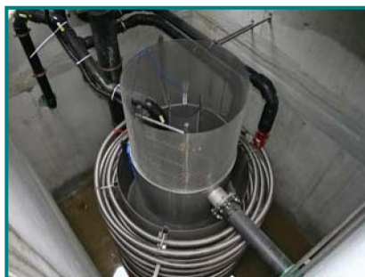
Scambiatore di calore collocabile sul collettore di scarico degli edifici
