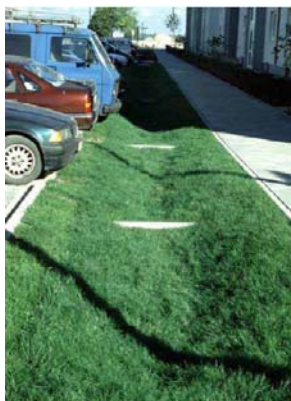
Trincee filtranti
