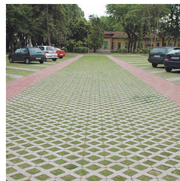
Pavimentazioni permeabili
