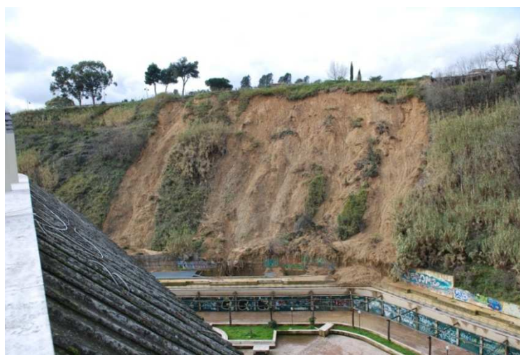
Figura 5 – Via Pietro De Cristofaro - Frana sul versante orientale di Monte Ciocchi, con danni su un complesso di garage.
