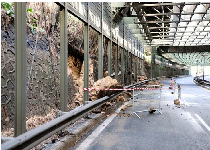
Figura 7 – Via Olimpica, tra Cassia e Galleria Giovanni XXIII. Frana che ha interessato il muro di contenimento del versante, posto a protezione della strada, per un tratto di 50 m.
