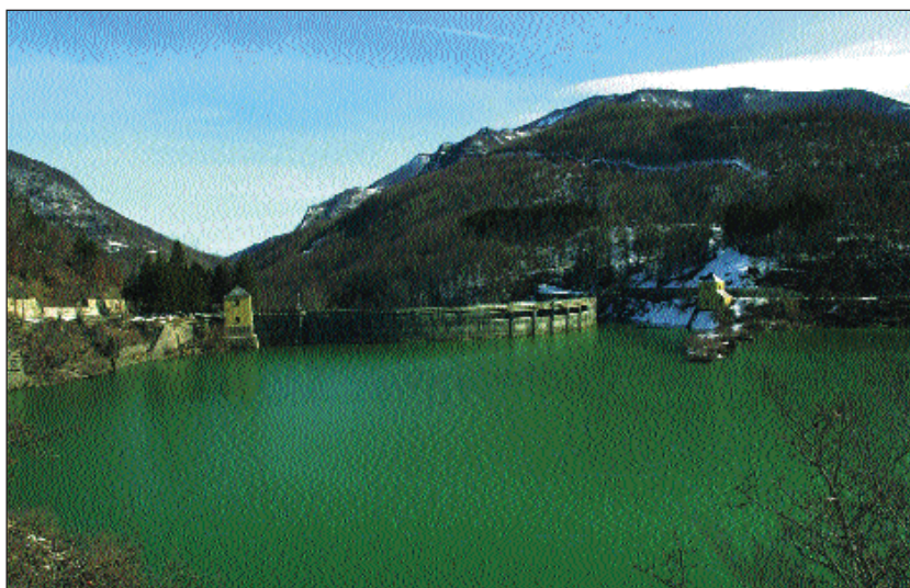
Figura 2 - Diga di Provvidenza (L'Aquila) Fonte: APAT
